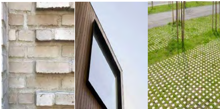
Eksempel på murdetaljer, fremtrukken ramme og græsarmering
